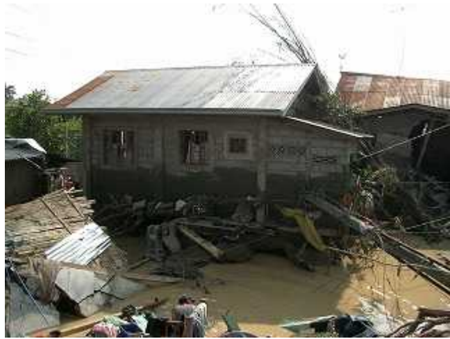
写真：アグノ川の破堤による被害
