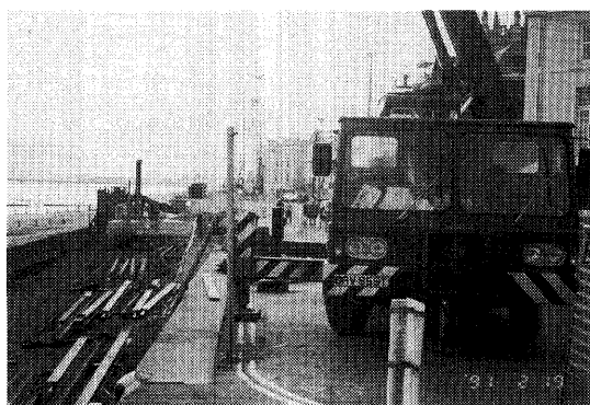
写真-16 トーキー市の防波堤工事
