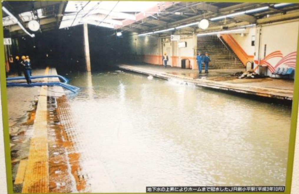
地下水の上昇によりホームまで冠水したJR新小平駅(平成3年10月)
